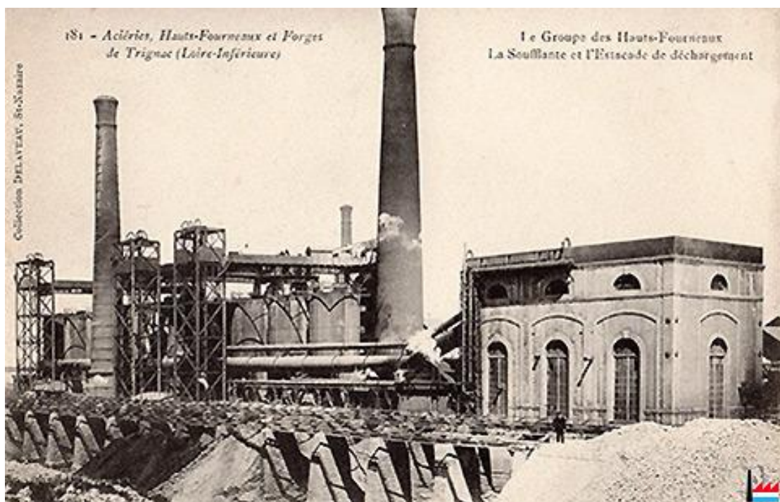
Aciéries, Hauts-Fourneaux et Forges et Trignac (Loire-Inférieure) - Le groupe des hauts-fourneaux avec fours à vent chaud Whitwell, tours cylindriques, la soufflante et l'estacade de déchargement Carte postale: Collection Delaveau, St-Nazaire. Collection : industrie.lu
